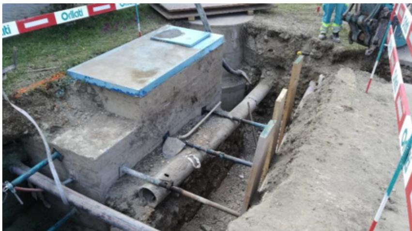
Le chantier de pose d'une nouvelle conduite d'alimentation en eau depuis Bousens, a débuté à mi-juin à la chambre de pompage du Crochet et s'est poursuivi le long du chemin du Poyet avant de passer à travers la zone agricole.
